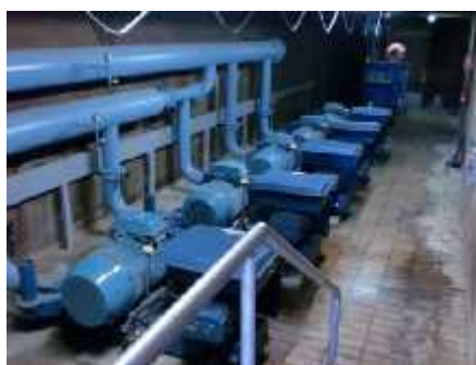
Il·lustració 9: Compresors que s'encarreguen d'insuflar l'aire - Font pròpia
