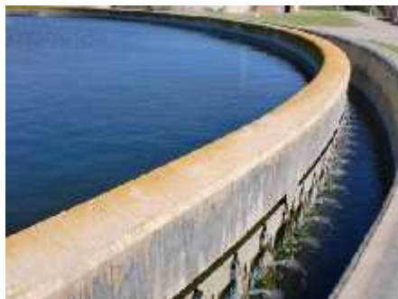
Il·lustració 10: Decantador secundari – Font pròpia
