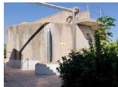
Il·lustració 13: Espessidor per gravetat –Font pròpia
