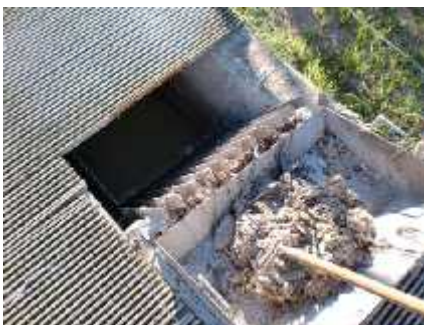
Il·lustració 2: Reixa de desbast - Font pròpia
