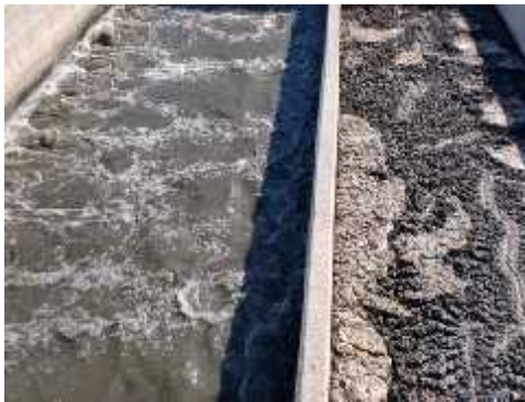
Il·lustració 5: Canal dessorrador - Font pròpia
