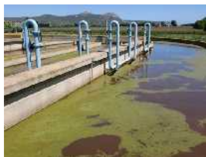
Il·lustració 8: Bassa d'aeració amb els col·lectors - Font pròpia
